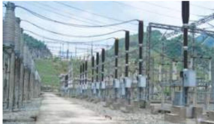
Máy cắt SF6 220KV 3AP1- FI245 /3150A (Nhà máy TD Hòa Bình)
